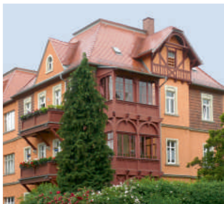
auf der Toeplerstraße
